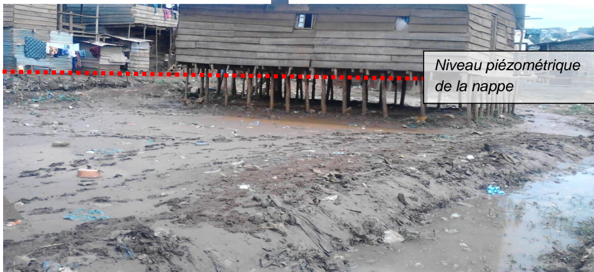
Figure 3c : construction d'une maison suspendue sur des bois (pilotis) au camp Luziba. Les traits rouges
